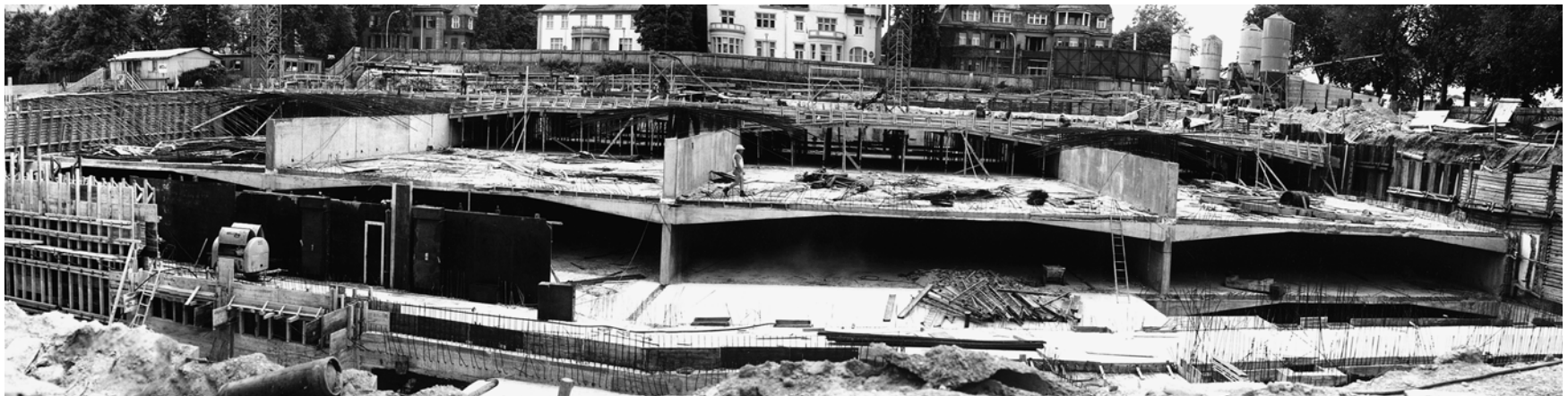
10 Tiefgarage zum Abgeordnetenhochhaus in Bonn, im Bau
