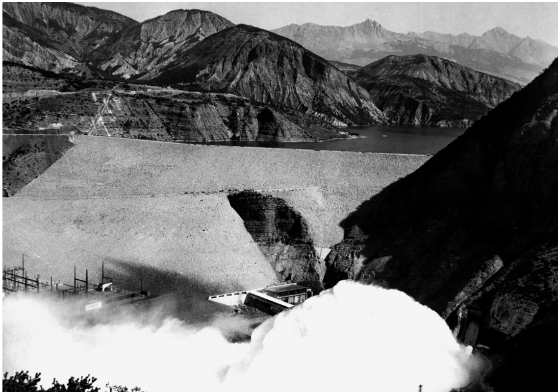
2 Barrage de Serre-Ponçon, Grundablaß geöffnet
